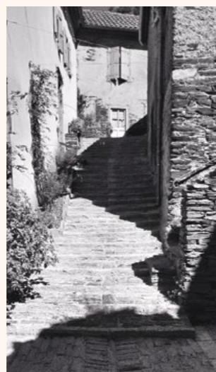
Après les travaux
