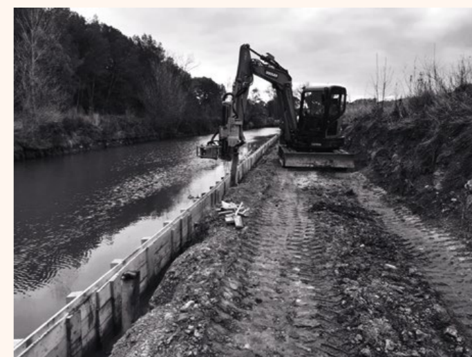
Pendant les travaux
