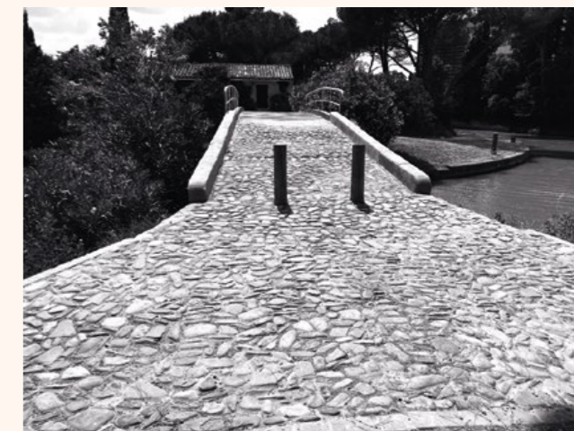
Passerelle Canal de Jonction
