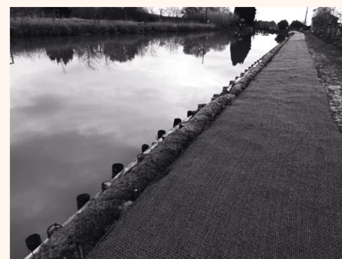
Travaux de contrebutement
