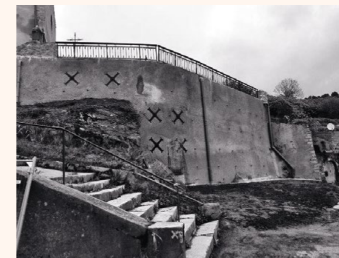
Après les travaux :
