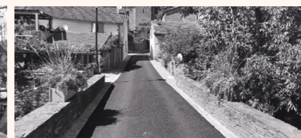
Après les travaux
