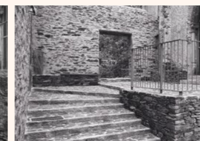
Après les travaux
