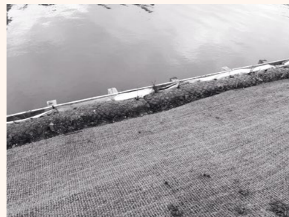
Travaux de tunage
