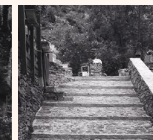
Après les travaux
