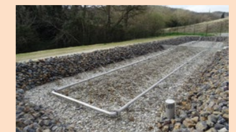
Après travaux (FPR, 180 EH)
