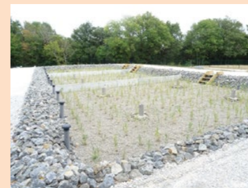
Station d'épuration de Villemagne après travaux (FPR, 180 EH)
