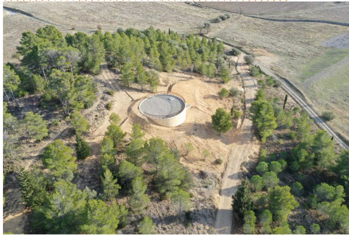
Réservoir d'eau potable de Fabrezan
