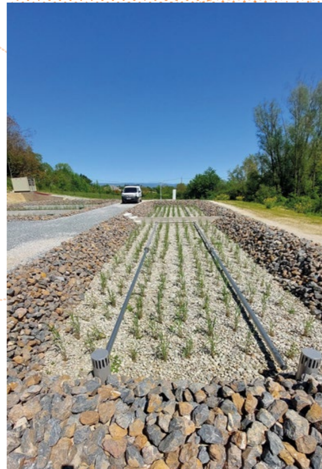
Station d'épuration de Mireval Lauragais
