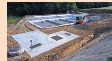
Pendant travaux (FPR, 130 EH)
