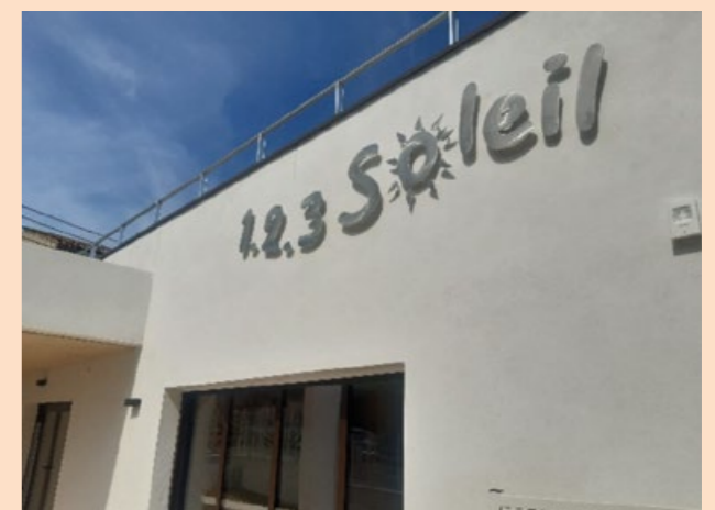
Photos de la réalisation
