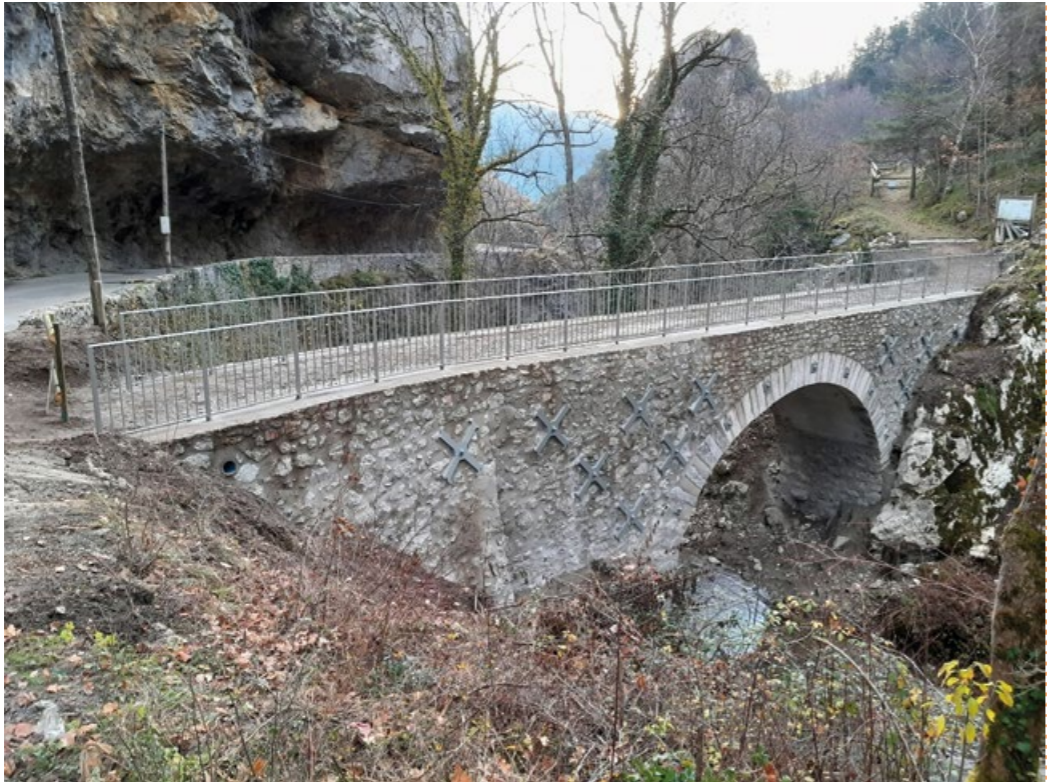
Ouvrage d'art à Joucou : "pont gaulois"
