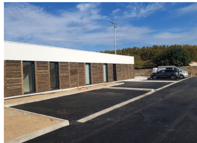
Centre de Santé Intercommunal de Lézignan Corbières
