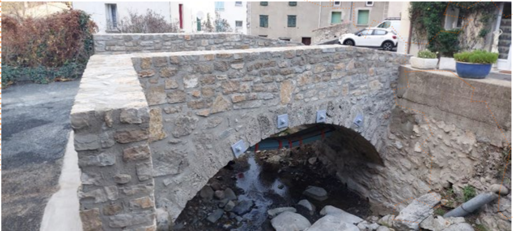
Ouvrage d'art à Salvezines
