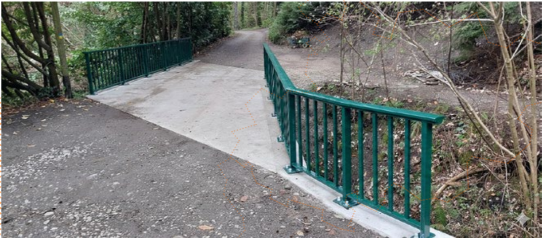
Ouvrage d'art du chemin du Thou à Cuxac Cabardès
