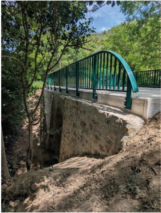
Ouvrage d'art à Villeneuve-la-Comptal
