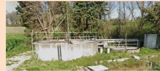
Avant travaux (Boues Activées, 400 EH)
