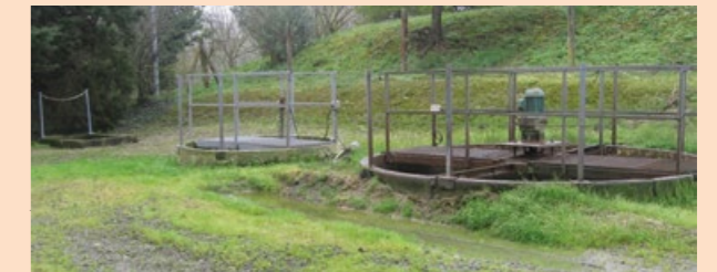
avant travaux (Boues Activées, 150 EH)
