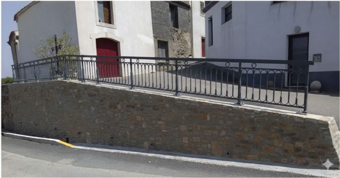
Mur de soutènement à Pauligne
