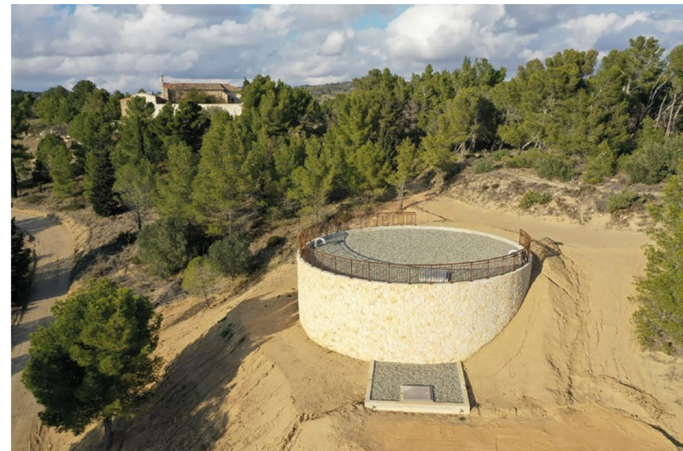
Réervoir d'eau à Fabrezan
