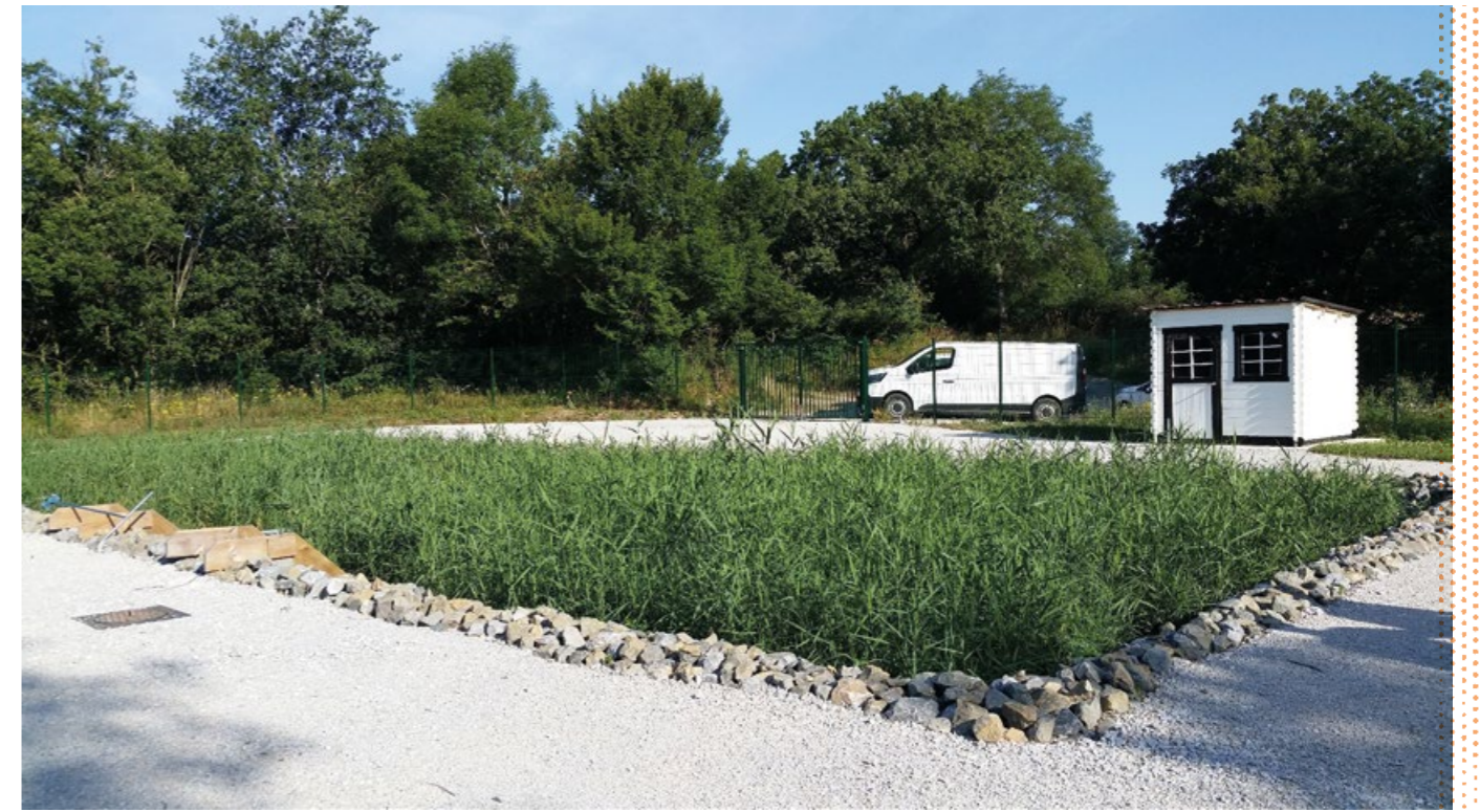
Station d'épuration de Villemagne
